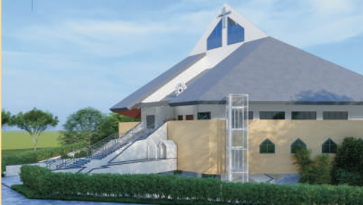
Tampak luar gedung
